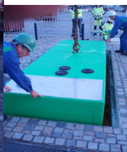
GE Ville de Concarneau Station de relavage d'eau 200Kva
