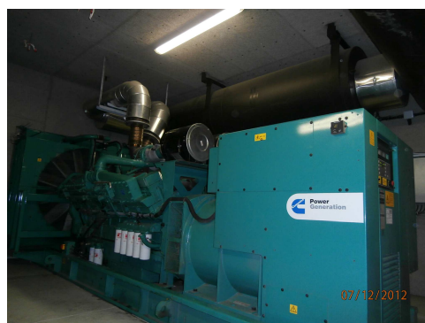
LECLERC Centrale Secours EJP secours 1250Kva
